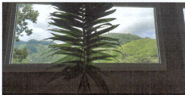
Foto: 6 instalaron ventanas PVC con su corredisa.
