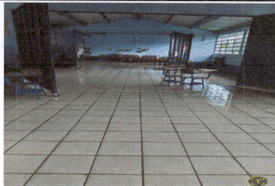
Foto: 2 En esta fotografía se observa que en las tres aulas se colocaron piso cerámico.
