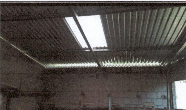
Foto: 3 Estructura de soporte y cubierta de láminas instaladas.
