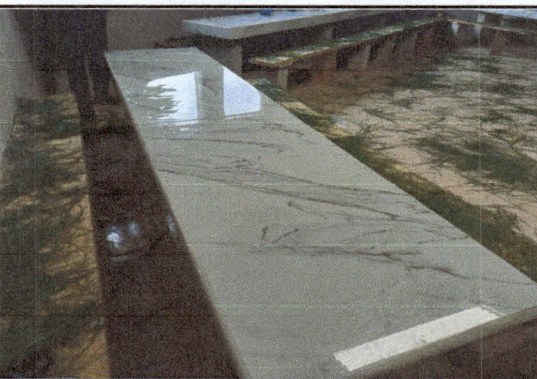
Foto: 4 En esta fotografía se observa la implementación de porcelanato y piso cerámico en el comedor del centro educativo.
