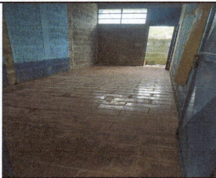
Foto: 5 implementación de piso cerámico en la bodega donde se va resguardar la Alimentación Escolar.
